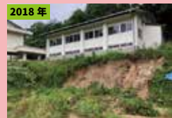
興東館柳生中学校の土砂くずれ
