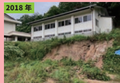
興東館柳生中学校の土砂くずれ
