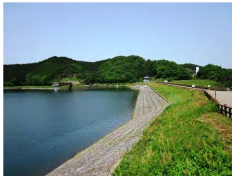
図表 4-27 倉橋ため池(のり面)
