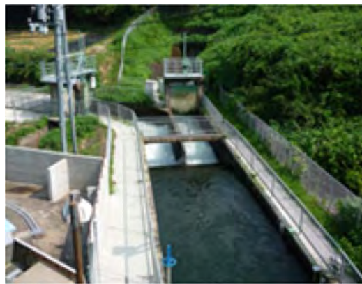
写真B: 東西分木工（御所市樋野）
